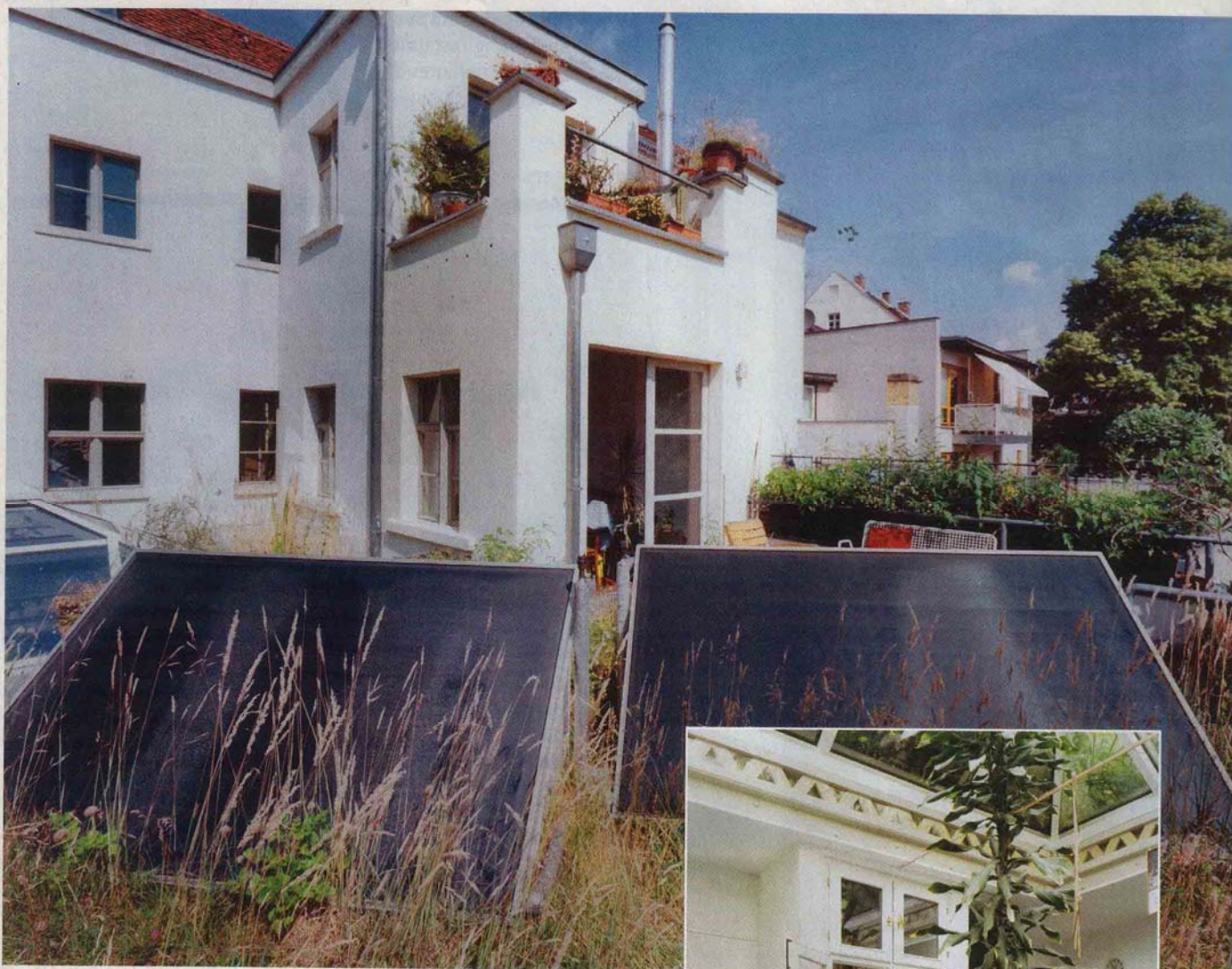
Die Rückfront zeigt sich nüchtern, bietet aber durch die beiden Freisitze viel Wohnqualität. Die Gestelle der Sonnenkollektoren dienen gleichzeitig als Oberlichte für die Büroräume. Links das Glasdach des Innenhofs.
